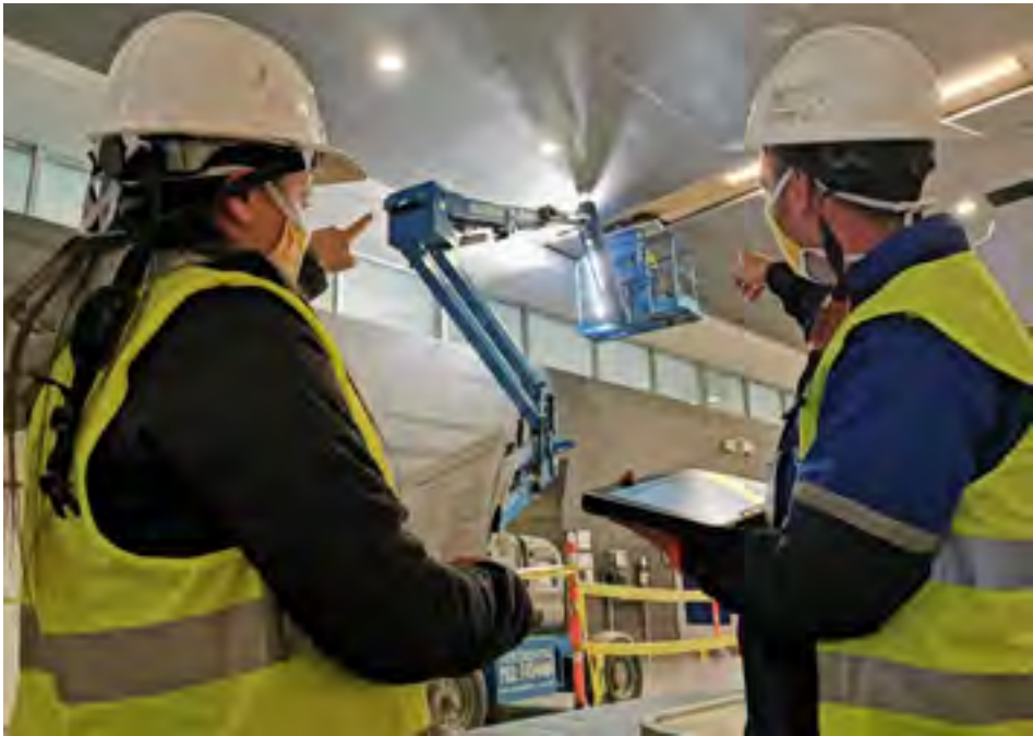
Cambio de luminarias en Aeropuerto El Dorado.
