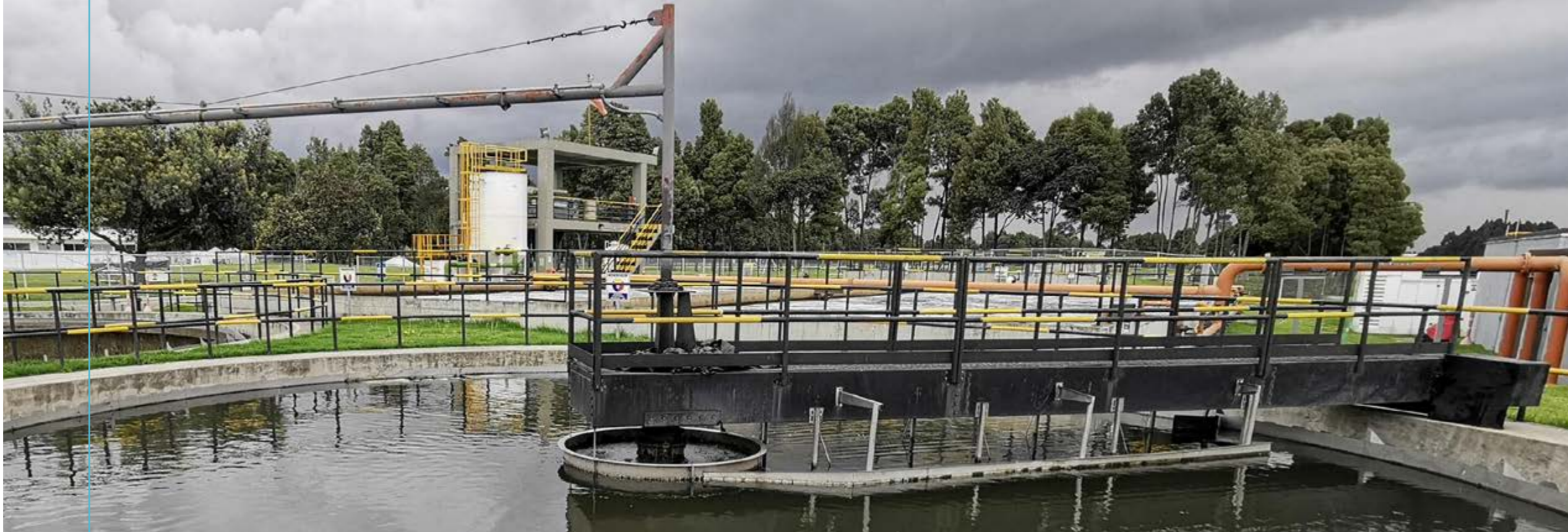
Planta de tratamiento de aguas residuales del Aeropuerto Internacional El Dorado.
