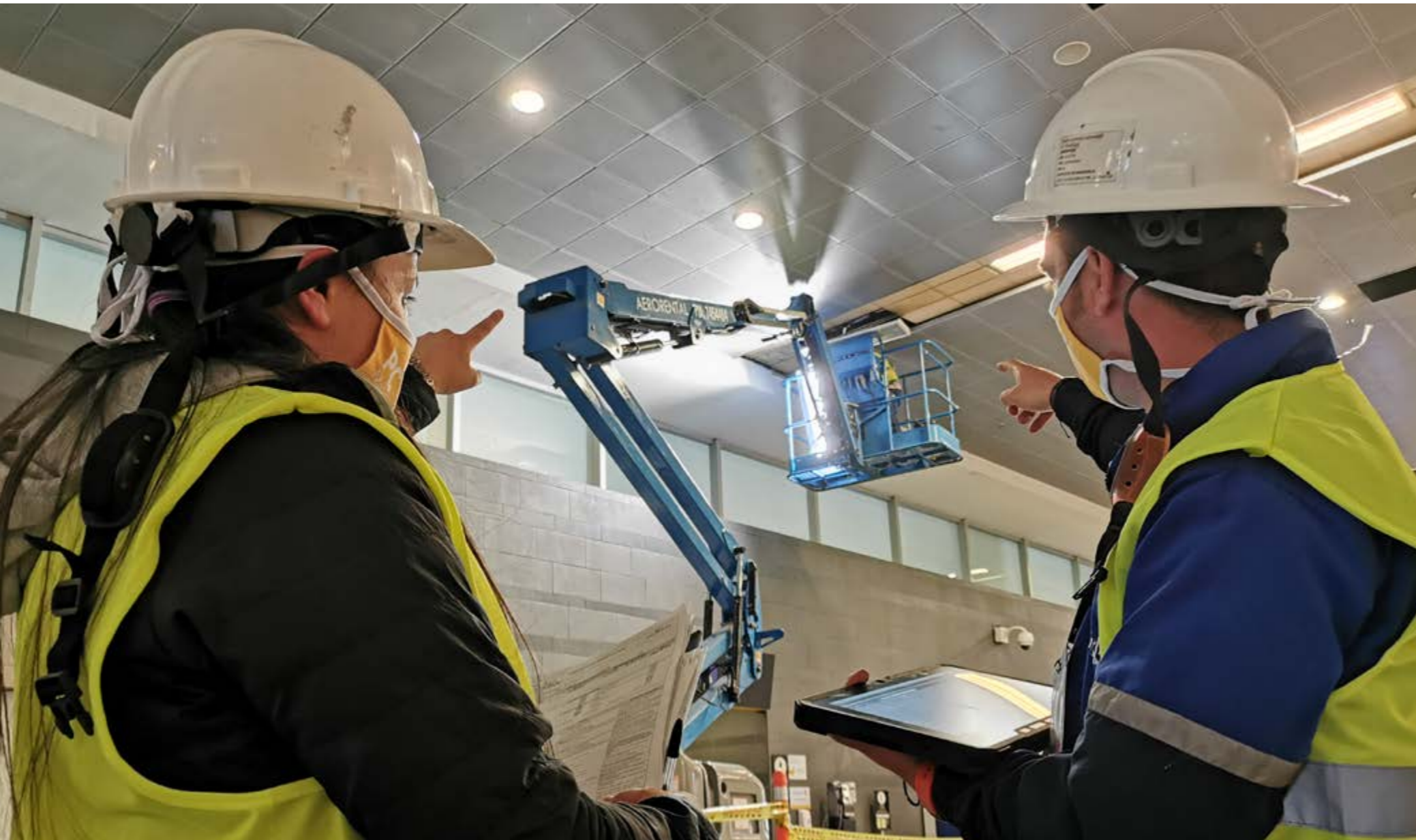
Programa Retrofit Lighting System aeropuerto El Dorado
