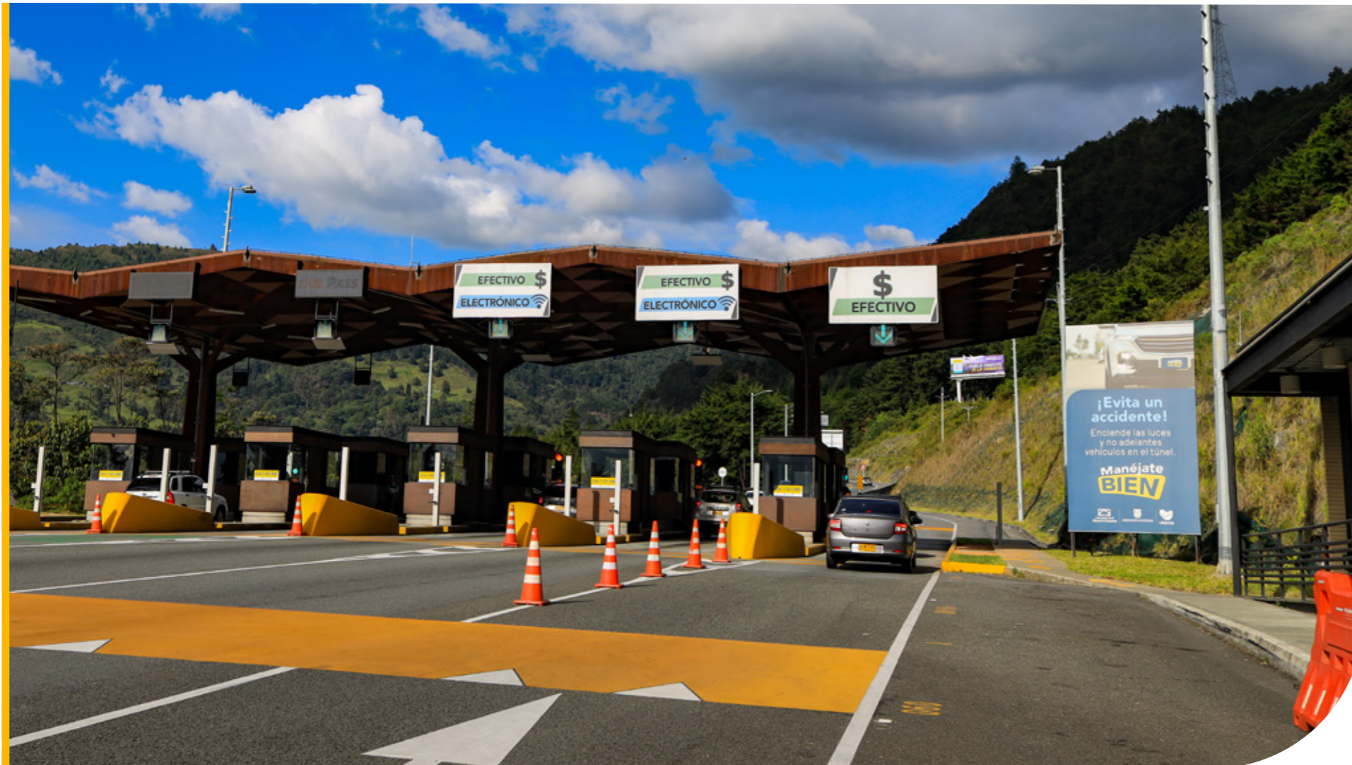
Túnel de Aburrá de Oriente
