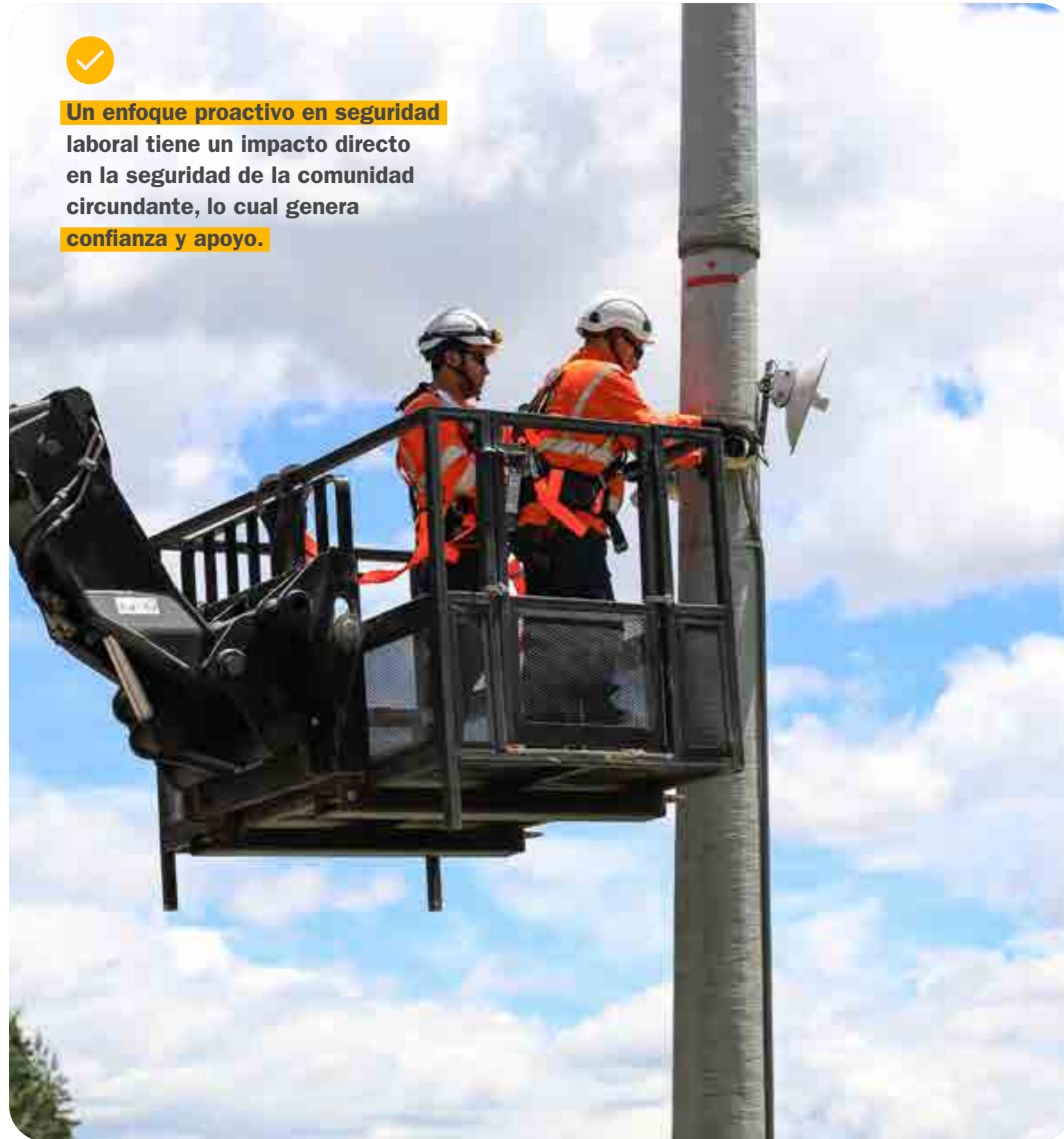
Labores de mantenimiento a la infraestructura vial
