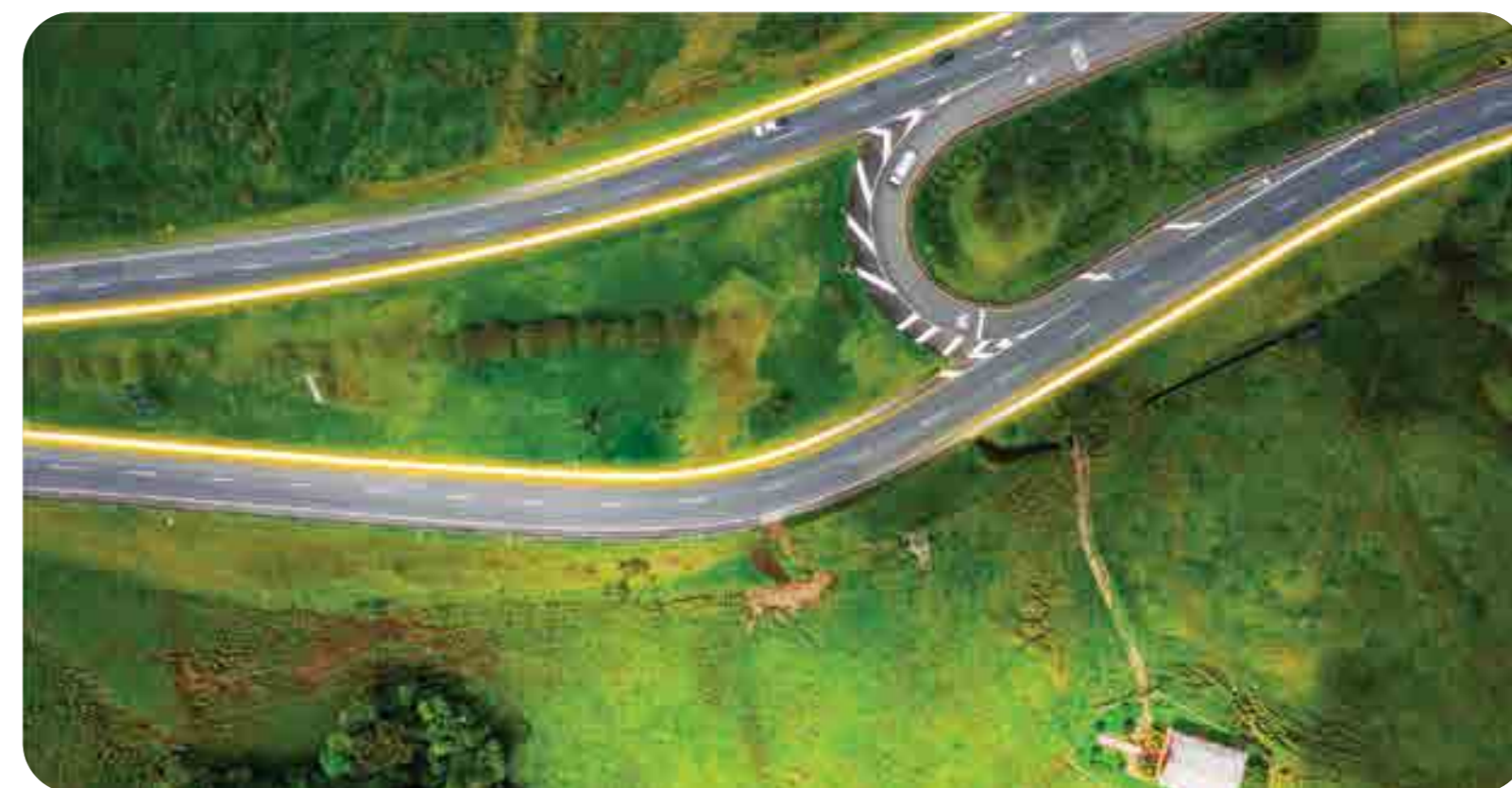
Infraestructura vial ▶ Autopistas del Café
