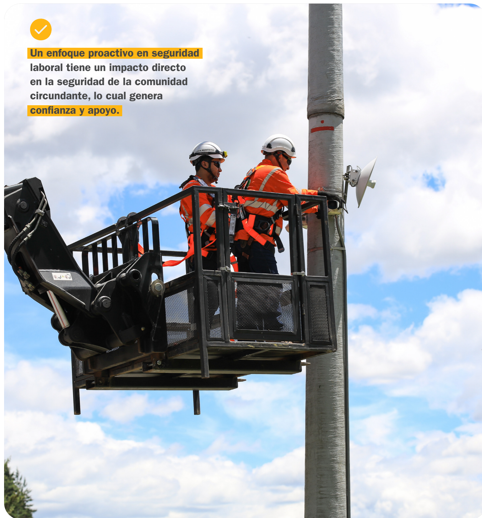
Labores de mantenimiento a la infraestructura vial
